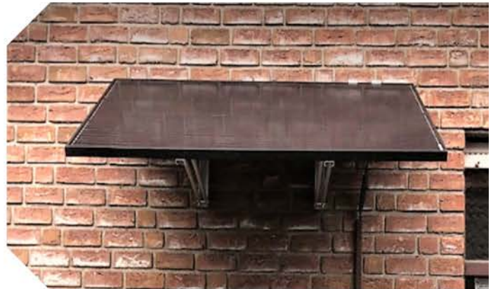
Abbildung 24, oben, unten und links: Befestigungsarten für Glas-Folie-Module (Bildquellen: Osnatec, ATON Solarparts, CarpeDiem Energy)
