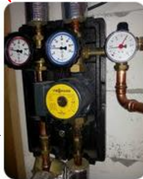
Solarthermie Pumpenmodul Viessmann Divicon
