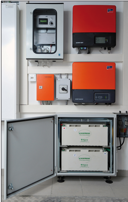
Bild 1: AC-Speichersystem mit Bleiakkus und Backup-Funktion
